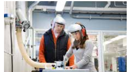
Oppilaitosten purun- ja tekstiilipölynpoistot
