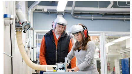
Oppilaitosten purun- ja tekstiilipölynpoistot
