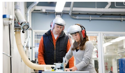
Oppilaitosten purun- ja tekstiilipölynpoistot
