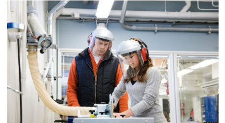
Oppilaitosten purun- ja tekstiilipölynpoistot
