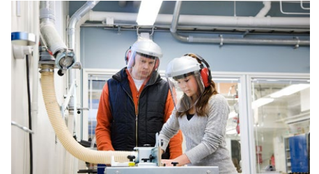
Oppilaitosten purun- ja tekstiilipölynpoistot
