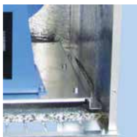
Asennettu värinänvaimentimien päälle
