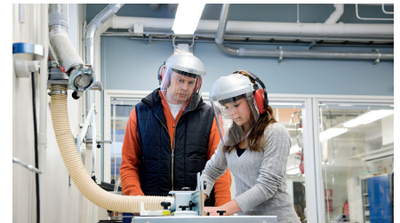
Oppilaitosten purun- ja tekstiilipölynpoistot
