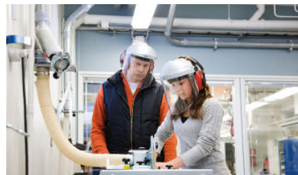
Oppilaitosten purun- ja tekstiilipölynpoistot
