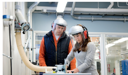
Oppilaitosten purun- ja tekstiilipölynpoistot
