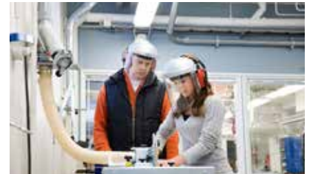
Oppilaitosten purun- ja tekstiilipölynpoistot
