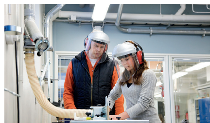
Oppilaitosten purun- ja tekstiilipölynpoistot
