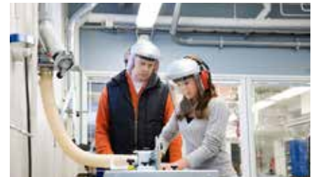
Oppilaitosten purun- ja tekstiilipölynpoistot
