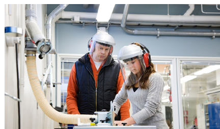
Oppilaitosten purun- ja tekstiilipölynpoistot
