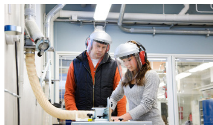
Oppilaitosten purun- ja tekstiilipölynpoistot
