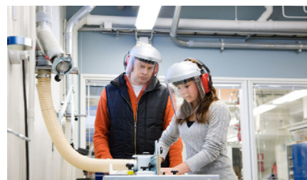
Oppilaitosten purun- ja tekstiilipölynpoistot
