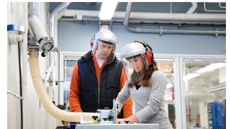
Oppilaitosten purun- ja tekstiilipölynpoistot
