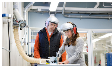
Oppilaitosten purun- ja tekstiilipölynpoistot
