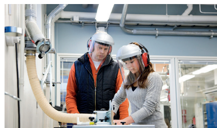
Oppilaitosten purun- ja tekstiilipölynpoistot
