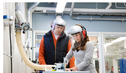
Oppilaitosten purun- ja tekstiilipölynpoistot
